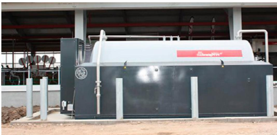
**Figura 4.1.** Equipo de acidificación de purines en fosa instalado en una granja danesa de producción lechera (Fuente: Universidad de Aarhus).
