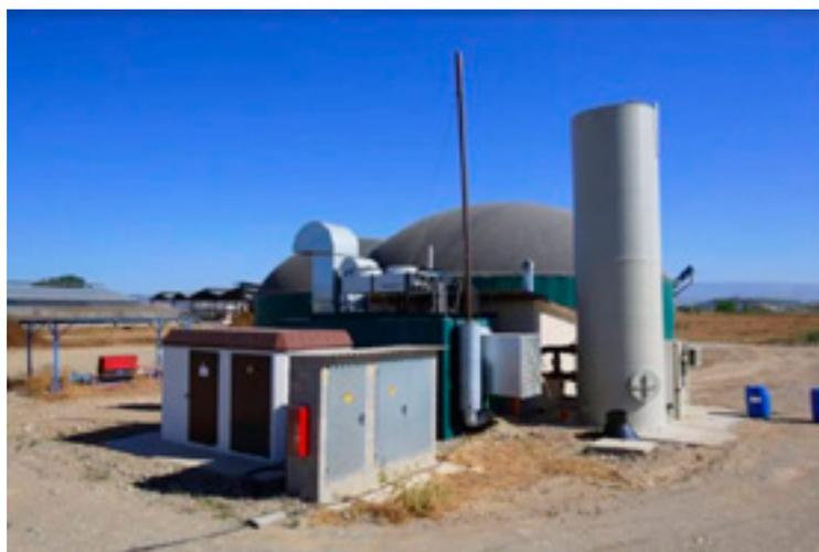
**Figura 5.4.** Primera planta de digestión anaerobia y de upgrading del biogás obtenido a biometano en una explotación ganadera de vacuno de leche (Granja Torre Santamaria, Lleida). Fuente: Retema (<https://www.retema.es/noticia/una-granja-de-lleida-primera-capaz-de-convertir-en-biometano-el-100-de-sus-residuos-o-0147j>)
