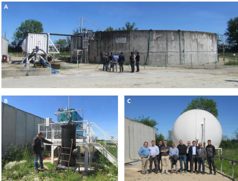
**Figura 2.** Planta de digestión anaerobia para el tratamiento de los purines generados en la granja experimental de producción lechera de Lamothe, de l'École d'Ingénieurs de Purpan: (A) digestor, (B) motor de cogeneración, y (C) gasómetro (fuente: IRTA, visita técnica en 2018).
